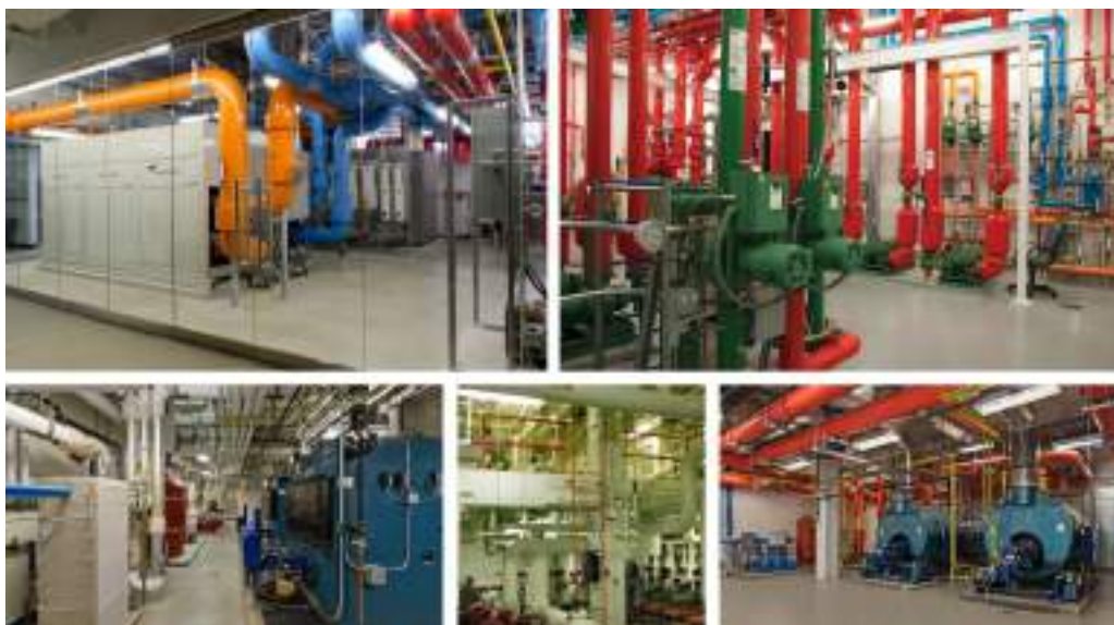
Slika 282. Tehničke / servisne etaže u visokim objektima
