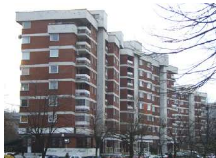
Slika 140: Stambena zgrada u Kovačićima, H. Salihović, 1980., Sarajevo
