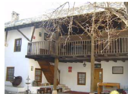
Slika 96: Hajat i tavan Bišćevića kuće, 17.st., Mostar
