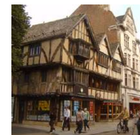
Slika 46: Fasade srednjovjekovnih kuća, Oxford
