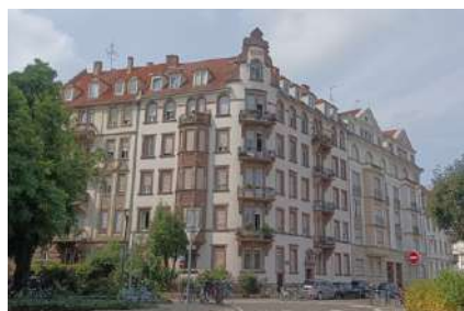
Slika 60: Fasada stambene uglovnice, 19.st., Strasbourg
