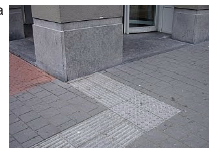
Sl. 347 - Taktilna traka bez smisla, traka koja vodi u zid, tj. nigdje
