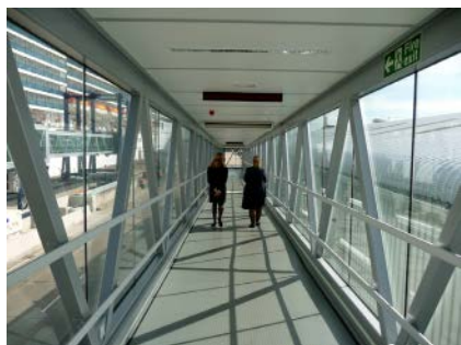
Sl. 208 - Unutrašnjost ukrcajnog mosta
