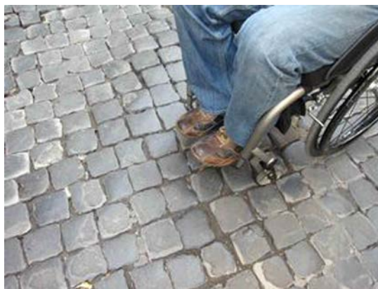
Sl. 444 - Podloga nepogodna za invalidska kolica
