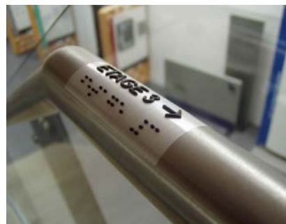
Sl. 322 - Rukohvat sa Brailleevom oznakom za nailazak na stepenišni krak
