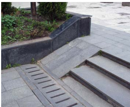
Sl.262 - Loše osmišljena kosina, bez rubnog nadvišenja i rukohvata, sa otvorima kišne rešetke u smjeru kretanja invalidskih kolica - opasna
