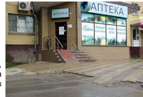
Sl. 260 - Kosina koja “prati” stepenište, neupotreblijiva bez obzira na rukohvate i po vlažnom vremenu pogibeljna i za zdrave
