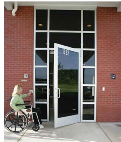
Sl. 329 - Smještaj tastera za otvaranje jednokrilnih automatskih vrata
