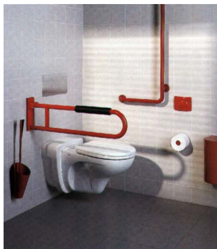
Sl. 416 - Pravilno projektirana, smještena i opremljena WC-šolja
