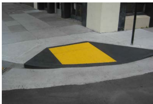
Sl. 124 - Dobro riješena kosina na trotoaru
