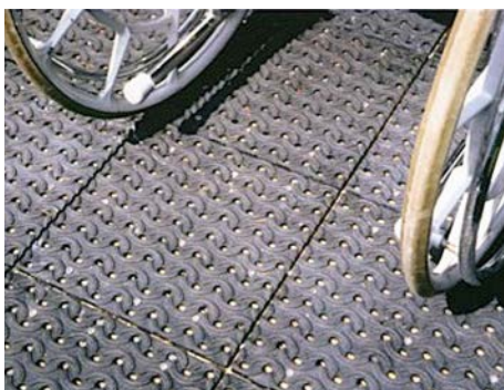
Sl. 256 - Odgovarajući materijal za gazeću površinu kosine
