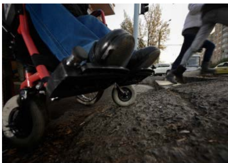
Sl. 257 - Pretjerano grub i nekoherentan materijal za gazeću površinu kosine
