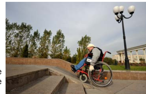
Sl. 261 - Kosine koje “prate” stepenište korisnici invalidskih kolica ne mogu samostalno savladati
