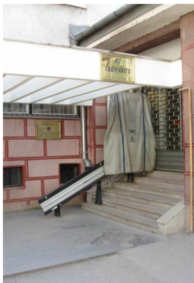
Sl. 450 - Pristup stepenišnom platformom Zavodu zdravstvenog osiguranja Kantona Sarajevo
