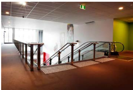
Sl. 243 - Početak stepeništa označen čepastom podlogom
