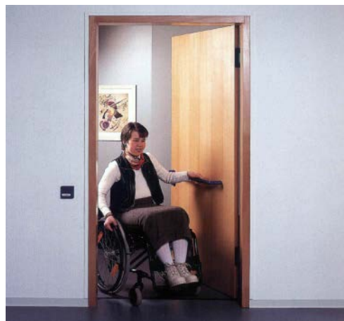
Sl. 218 - Rukohvat na krilu vrata, postavljen radi njihovog lakšeg zatvaranja
