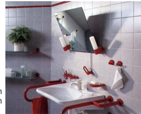
Sl. 404 - Pravilno projektiran i pozicioniran umivaonik, opremljen potrebnom opremom
