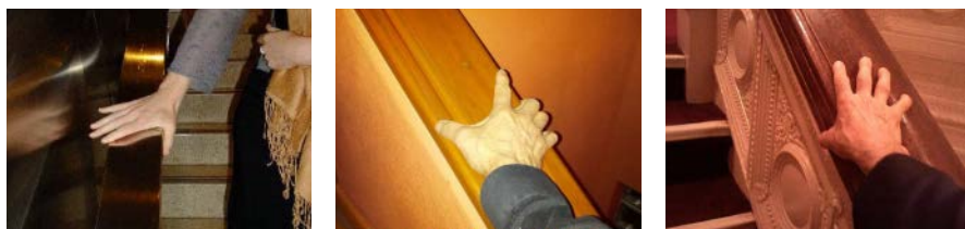
Sl. 316 do sl. 318 - Rukohvati koji uopće ne omogućavaju hvat
