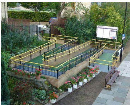
Sl. 255 - Odgovarajući materijali za pojedine elemente kosine
