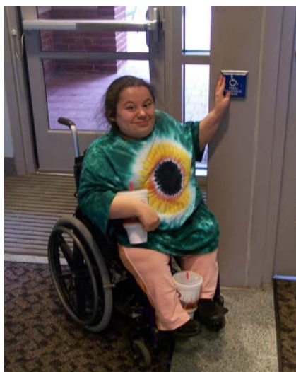
Sl. 327 - Ispravan smještaj tastera za otvaranje automatskih vrata
