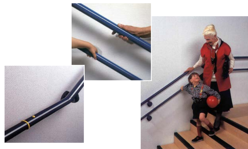
Sl. 244 do sl. 246 - Pravilno riješen i označen rukohvat
