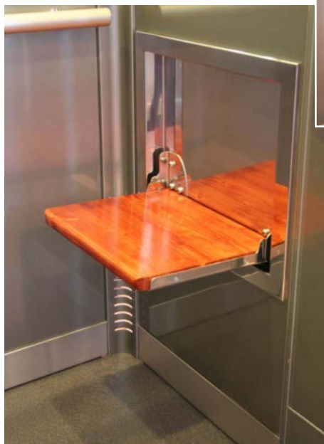
Sl. 288 i sl. 289 - Preklapno sjedište u liftu za nemoćne
