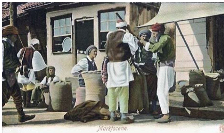
Sl. 135 - Neoznačeni dućan izgrađen lijevo od objekta kat. br. XXVII/58
