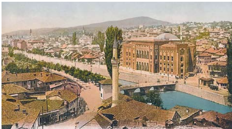
Sl. 75 - Novoizgrađene tramvajska mimoilaznica i stanica na desnoj i tačno nasuprot njih, na lijevoj obali Miljacke, prebačena Inat kuća, obje uzvodno od ćuprije
