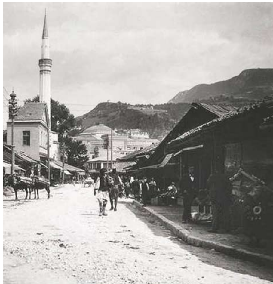
Sl. 159 - Kratki potez južne strane Nove teste između samog istočnog kraja Čemaluše i Halvadžiluka (desna strana slike). Obratiti pažnju na uredno postavljeno ivično kamenje trotoara, koje svjedoči o netom završenim radovima na saobraćajnici. U pozadini se vidi Vijećnica, proviruje tek izgrađena Beledija, a ispred je han Mehage Kestendžića.
