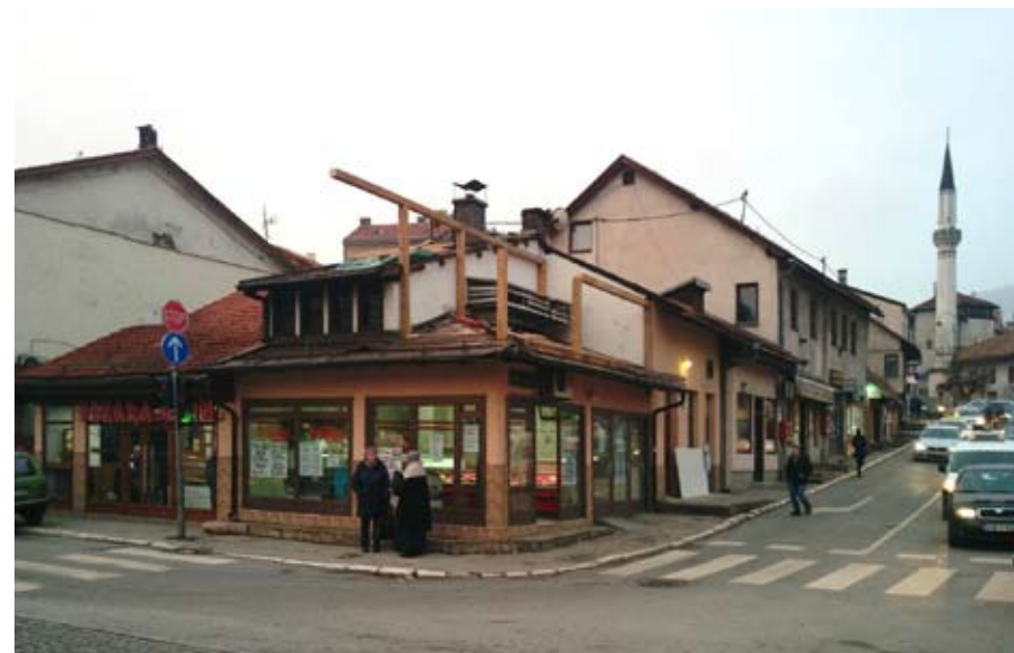
Sl. 22 - Pokušaj munjevitne bespravne nadogradnje objekta na veoma uočljivom i prometnom mjestu na Čaršiji (ugao Sagrdžija i Čemaluše, 4. 1. 2018. g.). Drvena konstrukcija, u nadi da će sve biti okončano prije reagiranja nadležnih, postavljena je bez skidanja pokrova (crijep oblika ćeramide). Srećom, zamišljeni plan nije uspio.
