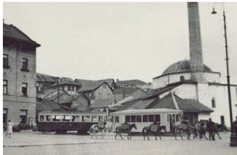
Sl. 152 - Tramvajska okretnica ispred Čekrekčijine džamije i spoj sa ulicom Miloša Obilića, današnjom Safvet-bega Bašagića
