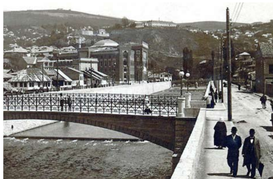
Sl. 74 - Dovršeni Vijećnica i kej u prvom planu i Inat kuća u sredini fotografije
