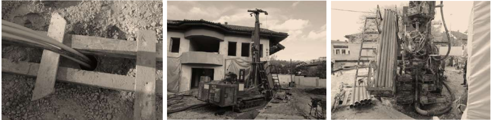
Fotografije 3.9. (a,b,c), Izgradnja niskoenergetske kuće u Sarajevu, projektant druge faze Haris Bradić, dipl. ing. arh., izvođenje geotermalnih bušotina, sustav sa četiri cijevi, fotografirano: 07.11.2012.
