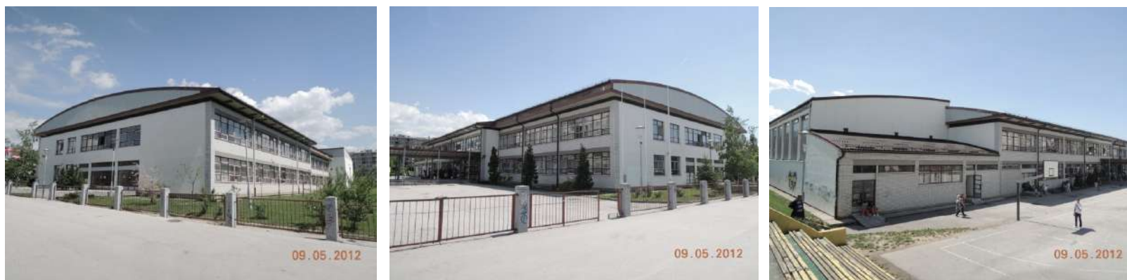
Fotografija 8.51. Zgrada JU OŠ Skender Kulenović u Sarajevu, (a) zapadna fasada, (b) južna fasada (c) istočna fasada, (09.05.2012)
