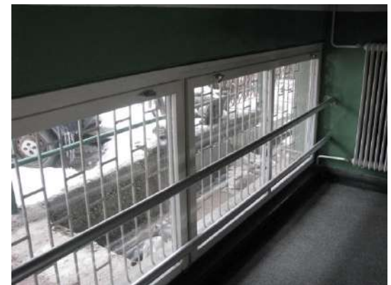
Fotografija 8.42. (a,b,c,d) Zgrada JU OŠ Hasan Kikić u Sarajevu, originalni vanjski otvori (24.12.2009.)
