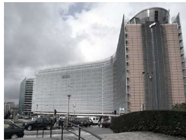
Fotografija 4.16. Zgrada Europske komisije nakon transformacije
