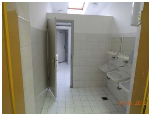
Fotografija 8.15. Zgrada JU OŠ Safvet-beg Bašagić u Sarajevu, sanitarni blok u etaži potkrovlja, (07.05.2012.)
