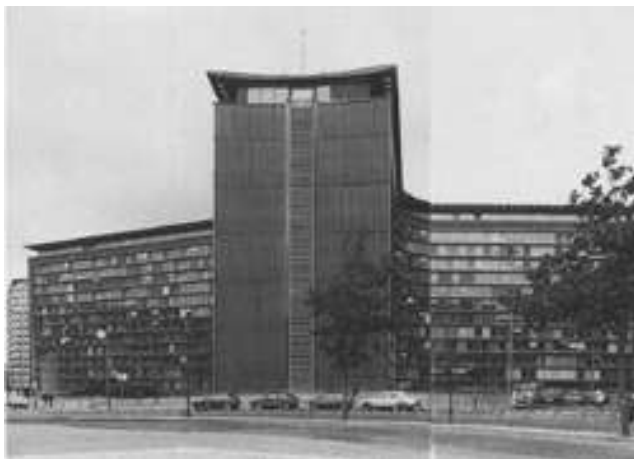
Fotografija 4.15. Zgrada Europske komisije prije transformacije
