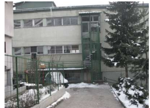
Fotografija 8.40. Zgrada JU OŠ Hasan Kikić u Sarajevu, (a) ulazno pročelje, (b) istočna fasada, (c) zapadna fasada (24.12.2009.)
