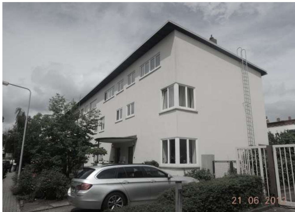
Fotografija 5.5, Energetska sanacija spomenika kulture, zgrada Ernst May u Frankfurtu, Njemačka, arhitekt Jürgen Werner , primijenjena VIP termoizolacija na fasadnoj strukturi, (21.06.2012.)
