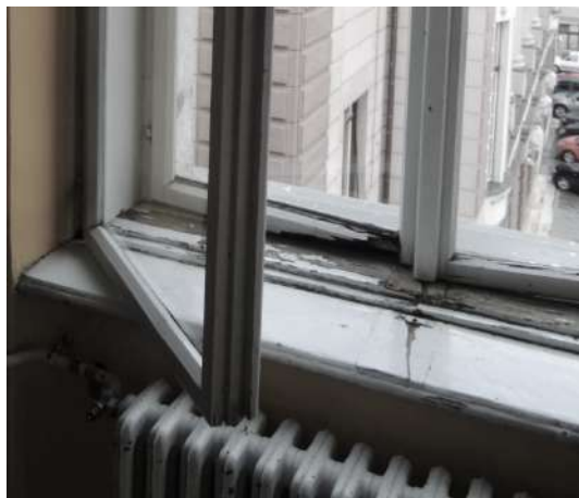
Fotografije 8.8 i 8.9. Fizička oštećenja vanjskih otvora zgrade JU OŠ Safvet-beg Bašagić (07.05.2012.)
