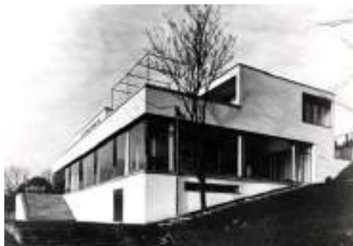
Slika 143. Mies van der Rohe, vila Tugendhat, Brno, 1930, tlocrti, originalni presjek, vanjski prikazi sugeriraju osnovni koncept na principu slobodnog plana što je omogućila lagana konstrukcija od krstatih čeličnih stupova obloženih kromom. Osnovna oblikovna izražajnost proizilazi iz analitičkog odnosa arhitektonske kompozicije i terena u kojem se kuća prilagođava terenu, a istovremeno zadržava integritet svoje geometrijske forme.
