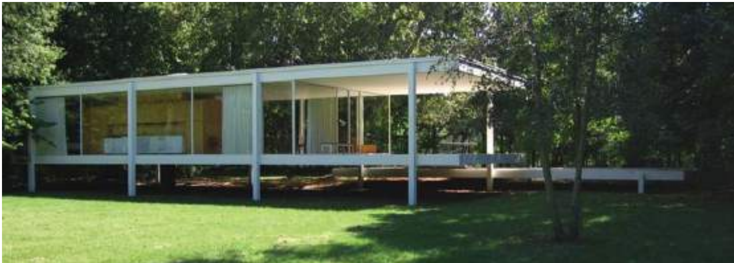
Slika 145. Mies van der Rohe, vila Farnsworth, Illinois, 1950. god. Slobodni plan transformiran do krajnjih granica u univerzalni prostor omeđen staklenim zidovima s konstruktivnim sklopom filigranskih dimenzija, koji stvara utisak odvajanja od tla, doprinosi da se ova kuća pojavljuje kao optička varka, kao fluid, objavljuje se svojim "neprisutvom" na terenu. Svako organsko srastanje s prirodom ovdje je nemoguće, jer je odbačen princip prilagođavanja terenu i usvojen princip namjernog distanciranja od zatečenog ambijenta.
