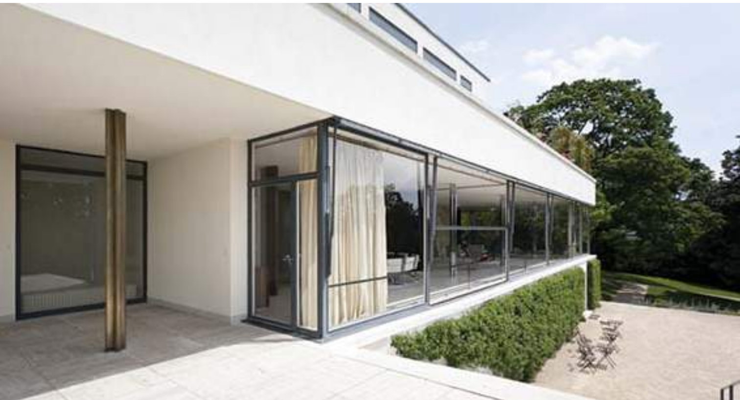
Slika 143. Mies van der Rohe, vila Tugendhat, Brno, 1930, tlocrti, originalni presjek, vanjski prikazi sugeriraju osnovni koncept na principu slobodnog plana što je omogućila lagana konstrukcija od krstatih čeličnih stupova obloženih kromom. Osnovna oblikovna izražajnost proizilazi iz analitičkog odnosa arhitektonske kompozicije i terena u kojem se kuća prilagođava terenu, a istovremeno zadržava integritet svoje geometrijske forme.
