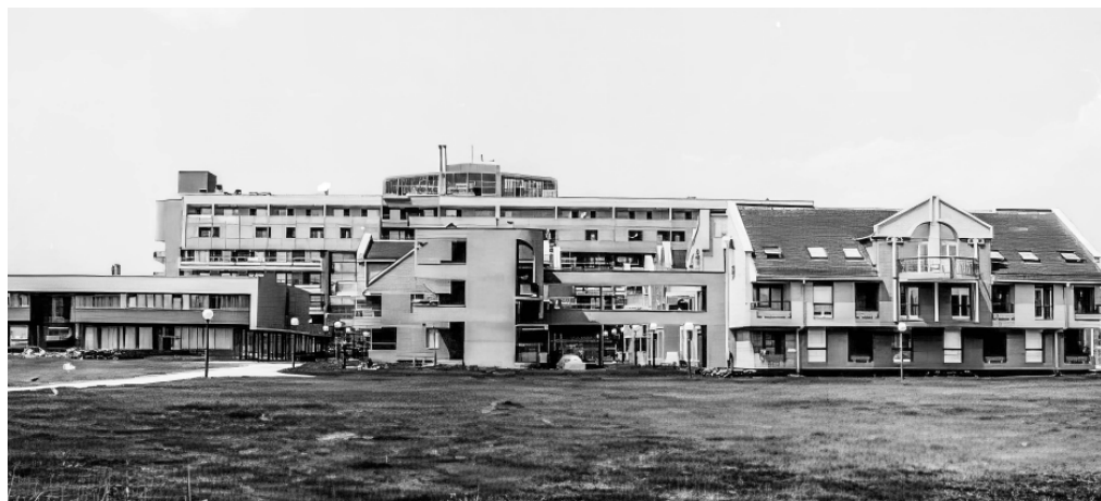
[153] Mladen Gvozden i Dragan Bijedić: Dom penzionera u Nedžarićima, Sarajevo, 1991. / Mladen Gvozden and Dragan Bijedić: Retirement Home in Nedžarići, Sarajevo, 1991
