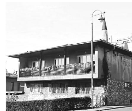
[102] Andrija Čičin Sain: Stambeni objekti u naselju Džidžikovac, Sarajevo, 1953. // Andrija Čičin Sain: Residential buildings in the Džidžikovac settlement, Sarajevo, 1953
