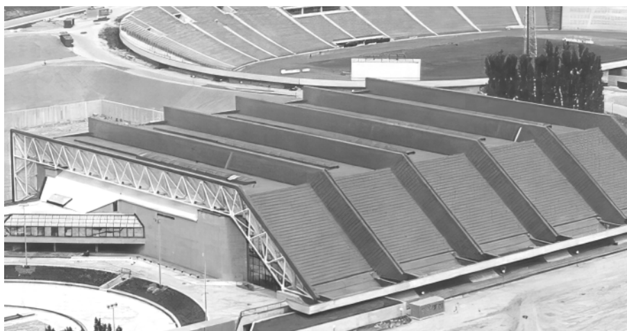
[139] Lidumil Alikalčić i Dušan Đapa: Kulturno-sportski kompleks „Zetra“, Sarajevo, 1982. // Lidumil Alikalčić and Dušan Đapa: Cultural and Sports Complex "Zetra", Sarajevo, 1982
