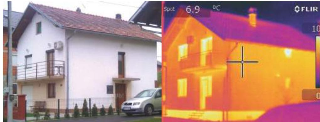
Slobodnostenjeća porodična kuća, spratnosti prizemlje i sprat. Krov je klasičan, drveni, na dvije vode, s crijevom kao krovnim pokrivačem. Spoljašnji zidovi su izvedeni od šupljih opekarskih blokova, debljine 29cm, sa slojem termoizolacije od 5cm u sistemu kontaktne fasade. Međuspratne konstrukcije su tipa TM3, a prema tavanском prostoru postavljen je sloj termoizolacije debljine 10cm. Prozori su jednostruki, s termoizolacionim staklom.
