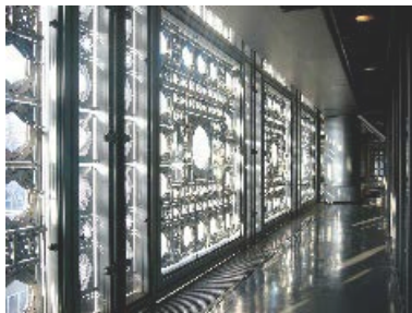
427 Institut du Monde Arabe, Pariz (1981.-1987.), Jean Nouvel +Architecture Studio, sa prepoznatljivom fasadnom opnom koju čine 240 fotosenzitivnih dijafragmi. 428 Detalj fasadne fotosenzitivne dijafragme na fasadi Institut du Monde Arabe, pogled iznutra.
