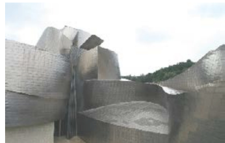
429 Temperirana stolica / Well Tempered Chair (1986.), Ron Arad. Materijali: čelični lim, leptir-matice i vijci. Dimenzije: 80 × 98,5 × 80 cm. 430 Guggenheim muzej, Bilbao (1997.), Frank Gehry: prepoznatljiva fasada od zakrivljenih panela od titanijuma.
