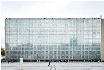
427 Institut du Monde Arabe, Pariz (1981.-1987.), Jean Nouvel +Architecture Studio, sa prepoznatljivom fasadnom opnom koju čine 240 fotosenzitivnih dijafragmi. 428 Detalj fasadne fotosenzitivne dijafragme na fasadi Institut du Monde Arabe, pogled iznutra.
